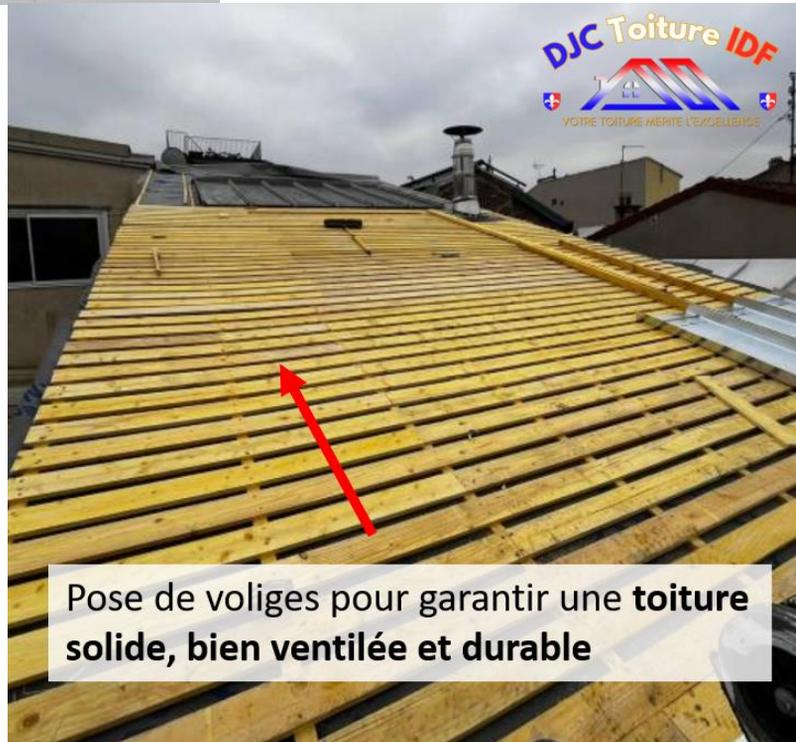
Pose de voliges pour garantir une **toiture solide, bien ventilée et durable**
