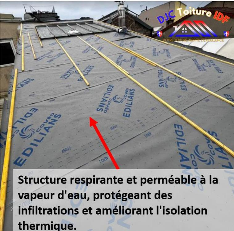
Structure respirante et perméable à la vapeur d'eau, protégeant des infiltrations et améliorant l'isolation thermique.
